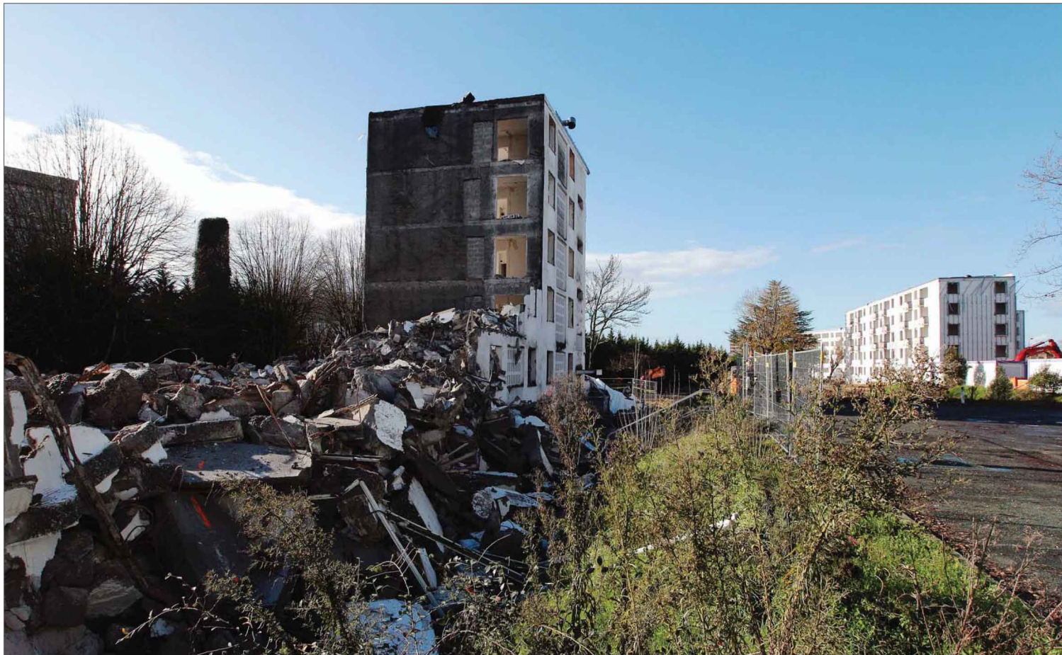
La cité Léo-Saignat en cours de démolition accueillera le pôle odontologie en 2018 et d'ici cinq ans, un laboratoire de recherche.
